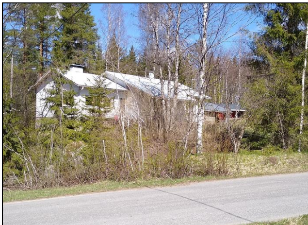
Entisen tilakeskuksen asuinrakennus ja piharakennukset
