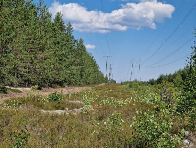
Kuva 1. Osa-alueen läpi kulkeva suurjännitelinja huoltototeineen. Kuvaussuunta itään.
