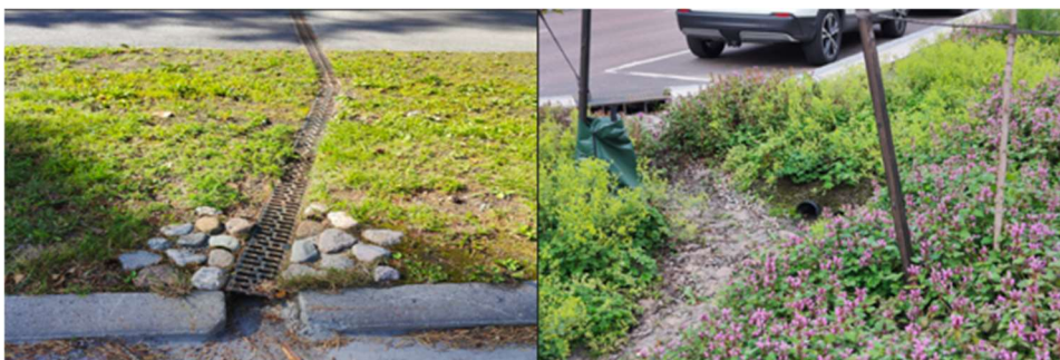
Kuva 15 Eroosiosuojattu hulevesien ohjaus nurmikon poikki viheralueelle (vasemmalla) ja hulevesien ohjaus kitakaivolla ja hulevesiputkella suodattavaan ja imeyttävään viheralueeseen jossa hulevesiuoman pohja on eroosiosuojattu soralla (oikealla). Kuva:Liina Kuittinen 2025
