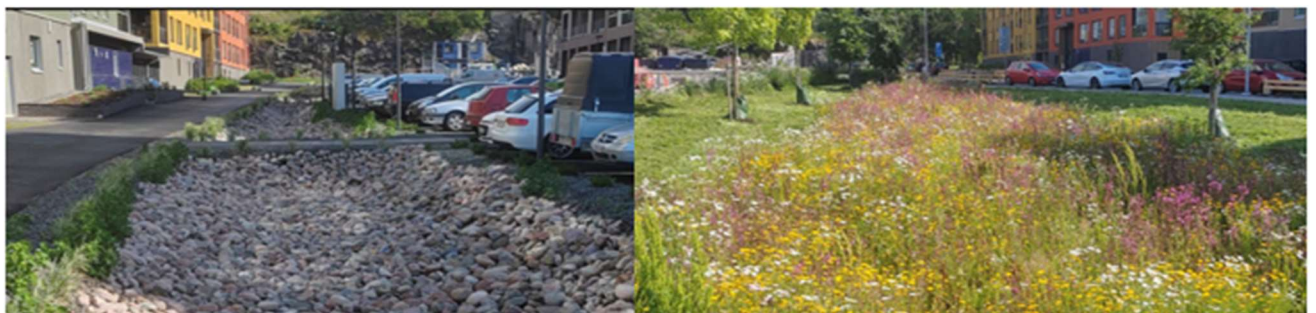
Kuva 19 Samalla ratkaisulla voi olla useampi ulkomuoto – viivytysohjaus- ja imeytyspainanteet toteutettuna kiviaineksella ja kukkivana ratkaisuna. Kuva: Timo Niemeläinen 2025
