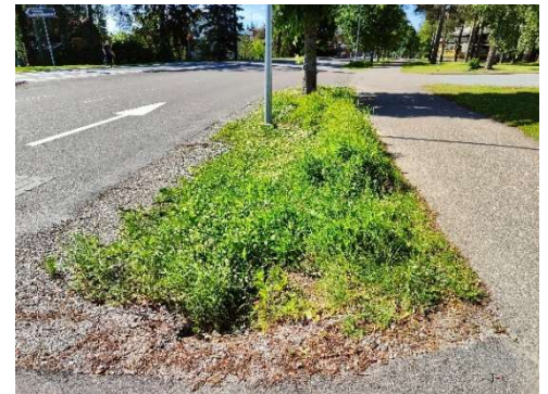
Kuva 18 Viivytysohjaus mahdollisesti sopiva kapeampi viherkaista.
