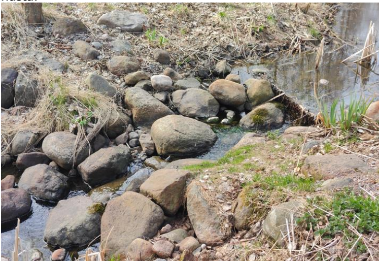
Kuva 7 Esimerkki kosteikon tulvauomasta, johon on sijoitettu kiviä ja veden virtausuoma laskee portaittain. Kuva: Liina Kuittinen 2025.
